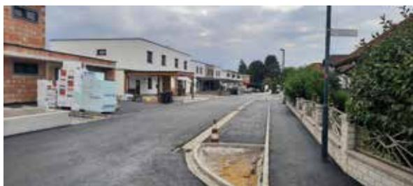
Zwischen Irnharting u. Wallnstorf wurde im Herbst mit der ersten Bauetappe der geplanten Geh- u. Radwegverbindung (Mehrzweckstreifen) begonnen. Vor der Ortseinfahrt Irnharting wurde ein Fahrbahnteiler zusätzlich als Querungshilfe errichtet.
